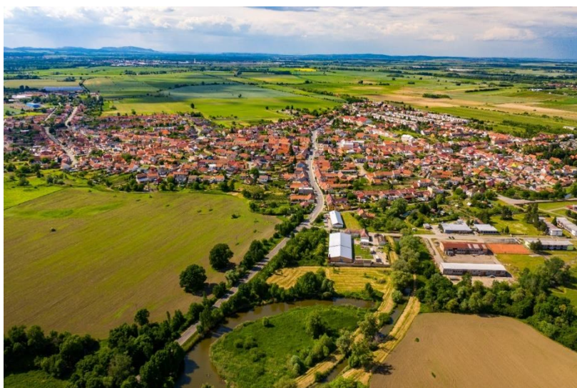
Obrázek 9: Letecký pohled obce Lanžhot, zdroj: obec Lanžhot
