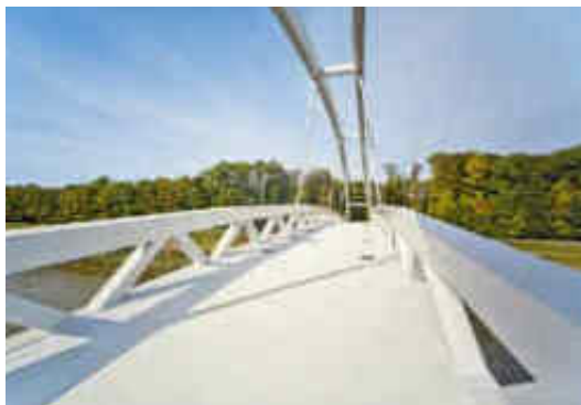
Lávka přes Moravu, foto: m-ARK
