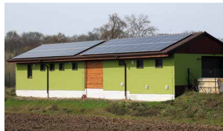
Fotovoltaická elektrárna na střeše čističky odpadních vod v Ladné
