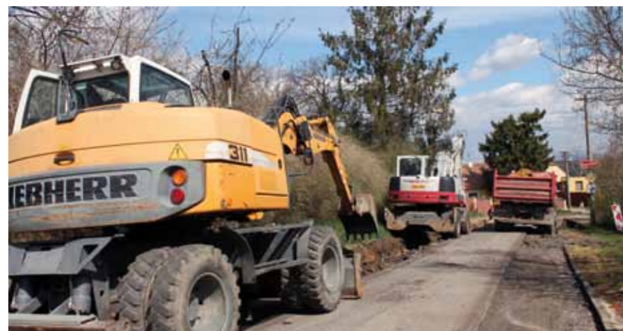
Práce na Poštovní ulici v Týnci
