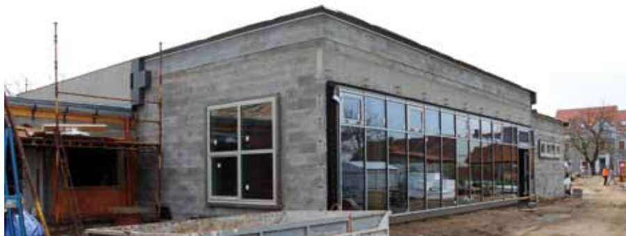
Práce na výstavbě nové mateřské školy a školní jídelny v Ladné
