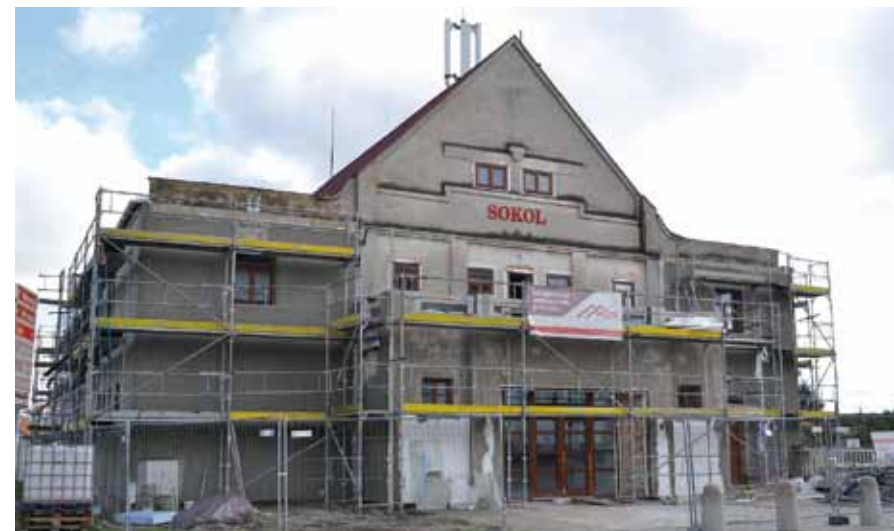
Rekonstrukce sokolovny v obci Lužice
