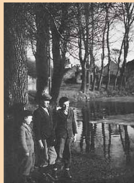
Záběr od zrušeného rybníka u zbrojnice
