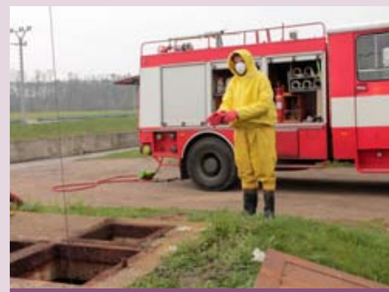
Čištění čerpacích stanic v kanalizaci
