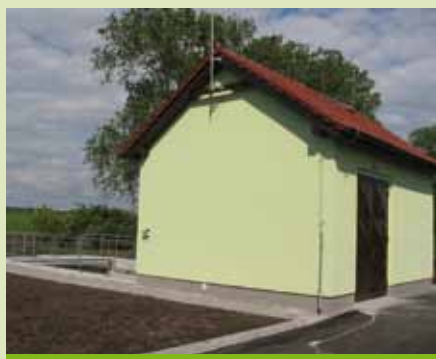
Budova přečerpávací stanice těsně po uvedení do provozu
