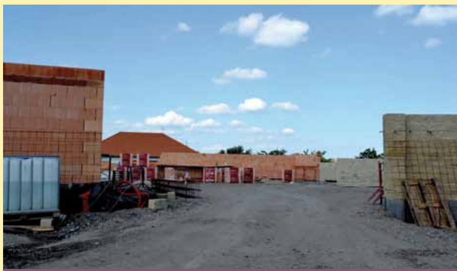
Výstavba sběrného dvora v Lužicích na jaře 2014
