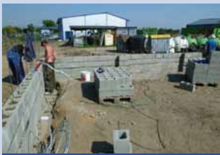
Výstavba sběrného dvora
