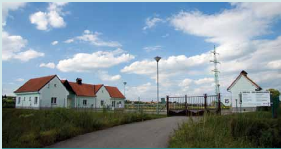
Stanice ČOV a kanalizace v Kosticích
