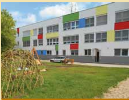
Mateřská škola po rekonstrukci
