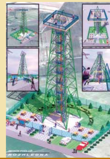
Regionální rozhledna bude vysoká 30 metrů a provedena jako celokovová pozinkovaná konstrukce. Snímek vlevo zachycuje budování základů.
